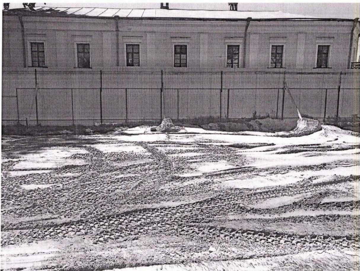
Фото 3. Земельна ділянка по завершенню робіт. Вид з півночі
