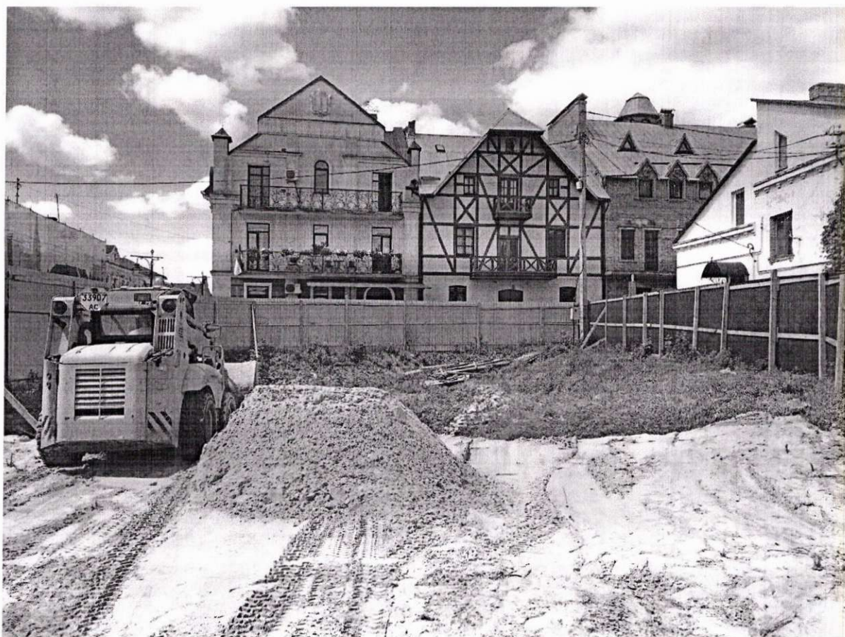
Фото 2. Земельна ділянка в процесі робіт. Складування та засипка піском. Вид зі сходу
